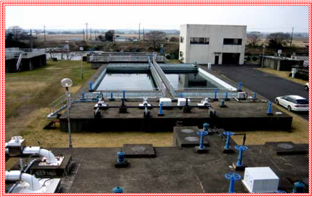
前新田浄水場 沈澱池
